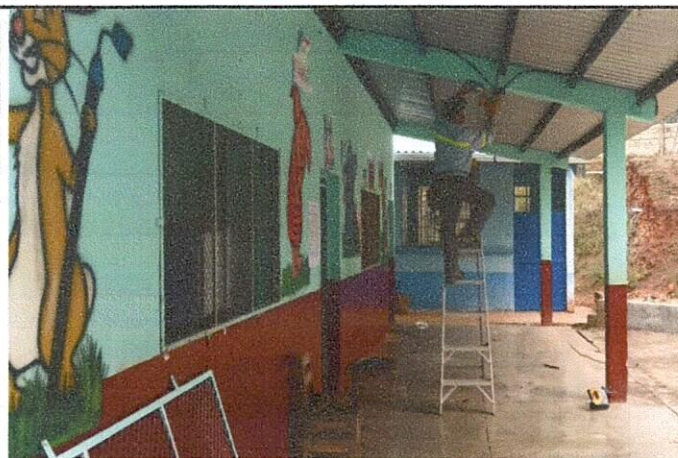
REPARACION Y MEJORAMIENTO DE INSTALACIONES ELECTRICAS DE AULAS Y COCINA
